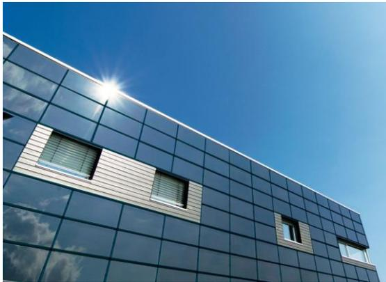
Beispiel einer möglichen Fassadenkonstruktion mit Solarenergie
